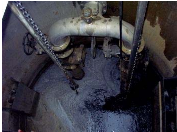
Einbau Pumpensumpf
