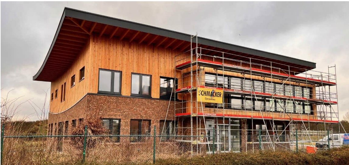
Bild: Süd-Ost Ansicht des im Bau befindlichen Betriebsgebäudes (Bild vom 07.01.2025)
