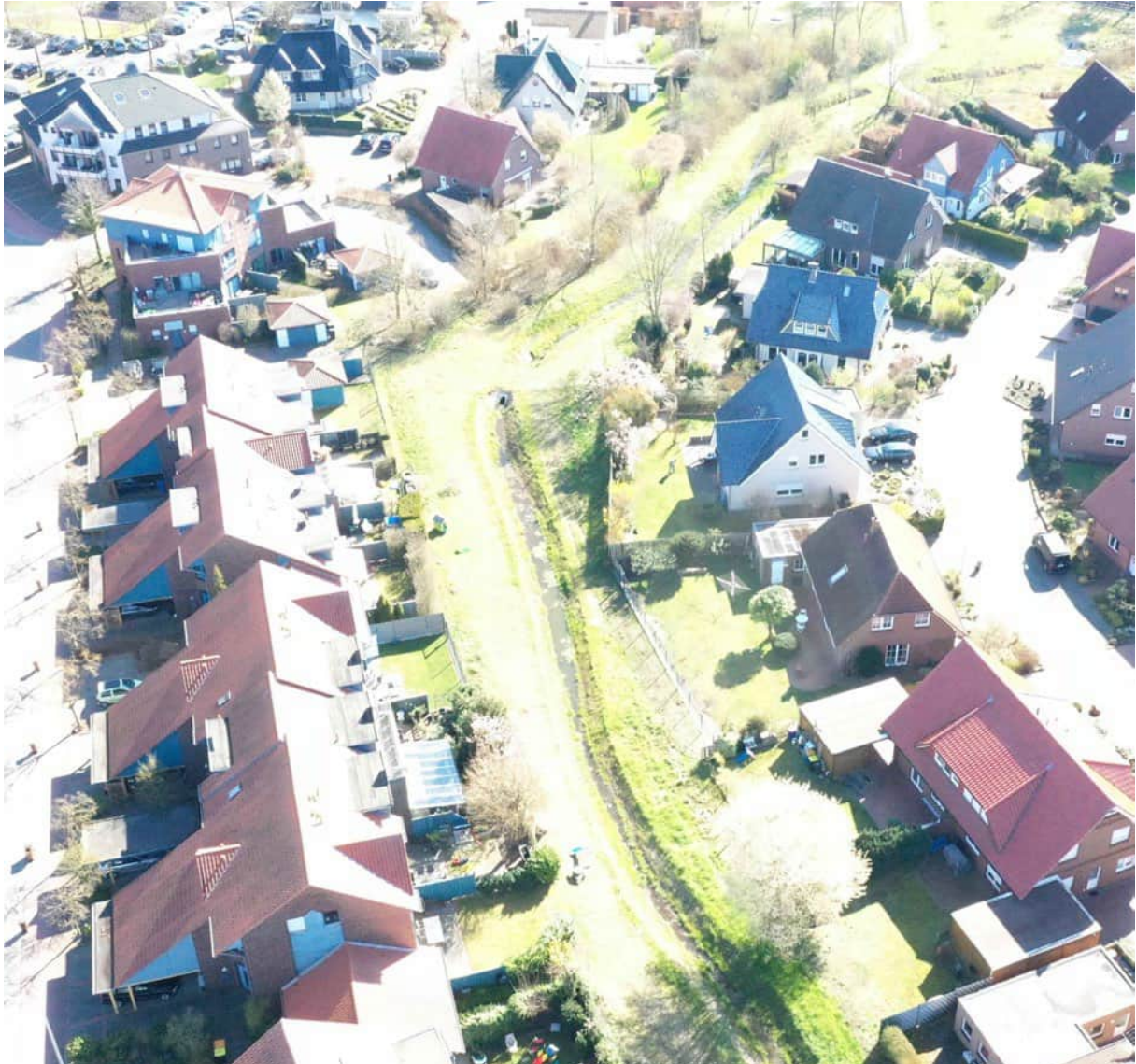
Bild: Aufgereinigter Graben
