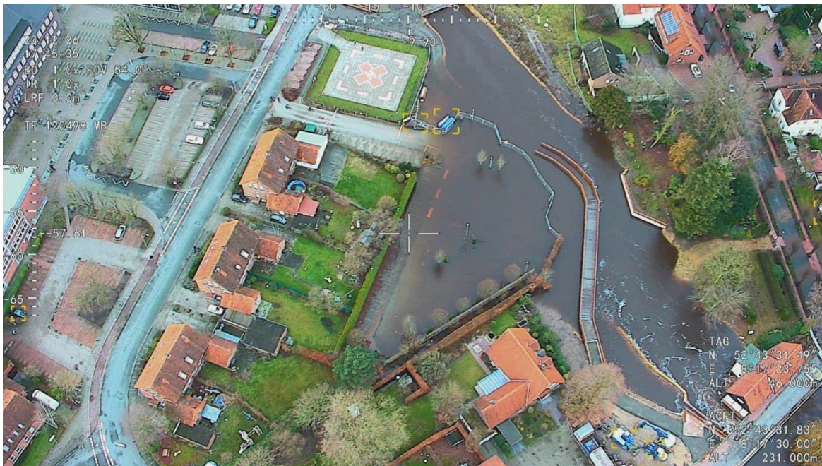
Bild: Hochwasserlage am 26.12.2023 Unterlauf des Moorbaches (Erstellt durch die Freiwillige Feuerwehr Vechta)
