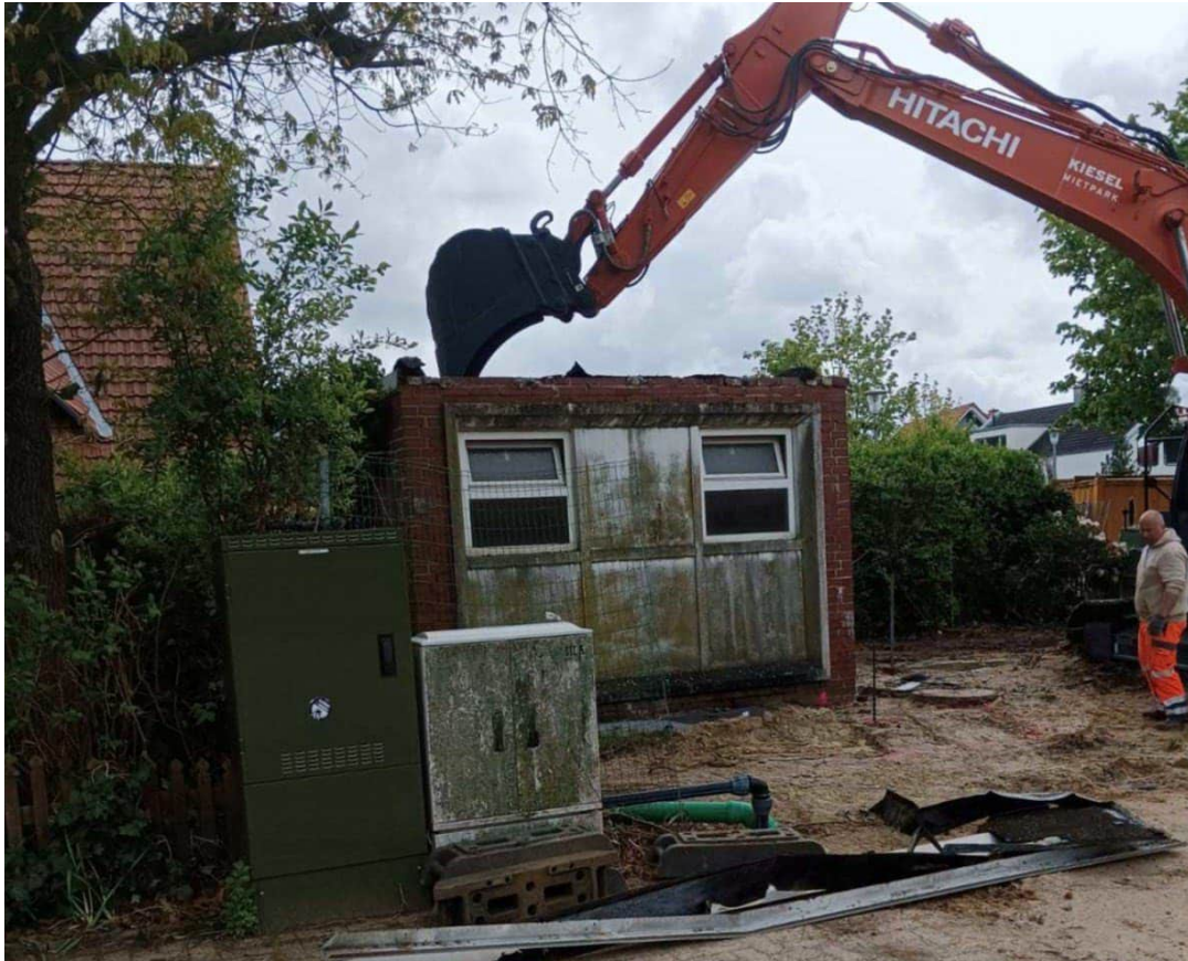
Bild: Abriss des alten Pumpwerkes
