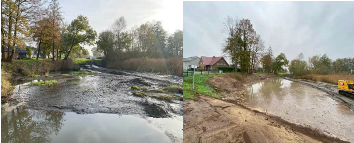
Bild: RRB o8 hinter RASTA Dome vor Aufreinigung Bild: RRB o8 hinter RASTA Dome nach der Aufreinigung
