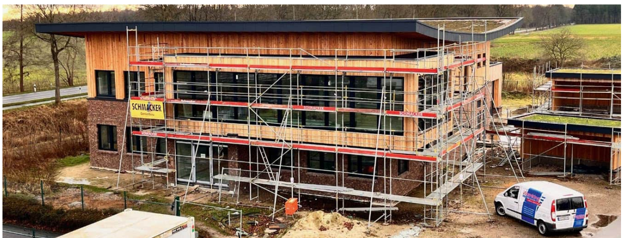
Bild: Ost Ansicht des im Bau befindlichen Betriebsgebäudes (Bild vom 07.01.2025)
