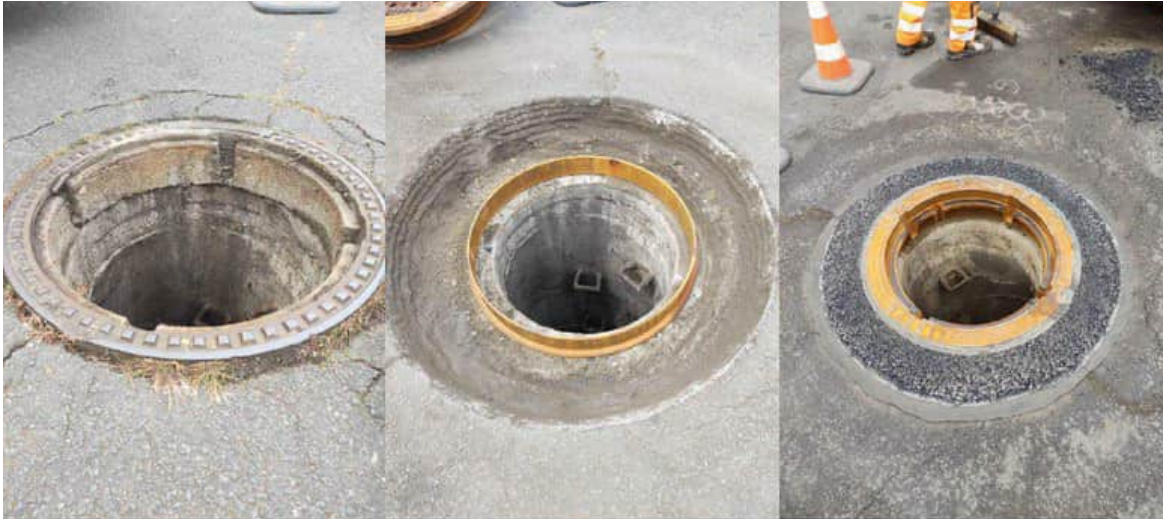
Schachtdeckel vor, während und nach der Sanierung
