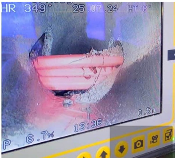
Glasfaserleitungen durch den Regenwasserkanal in der Oldenburger Straße
