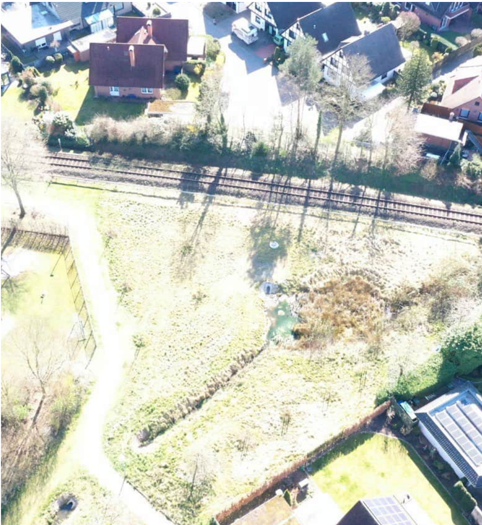
Bild: Neuer Auslaufbereich des Dükers
