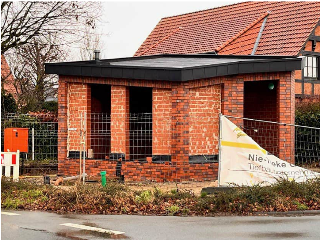
Bild: Süd-West Ansicht des im Bau befindlichen Hauptpumpwerkes (Bild vom 07.01.2025)
