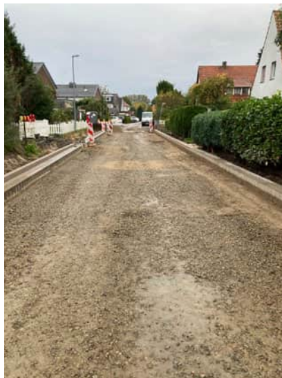
Schottertragschicht 2. Bauabschnitt
