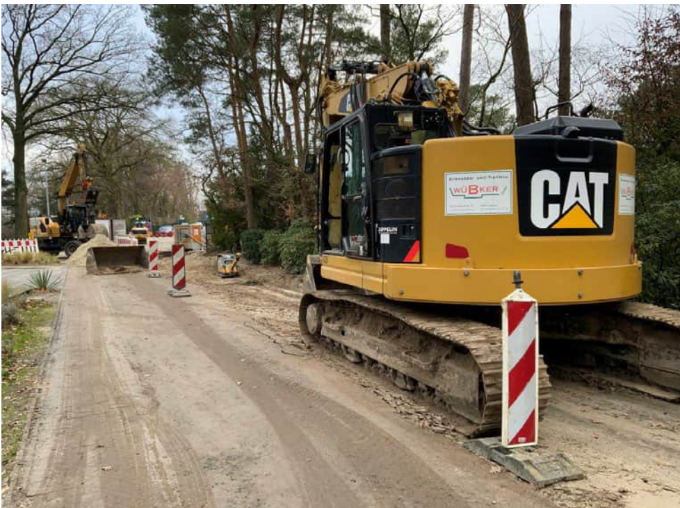
Welper Straße, halbseitiger Straßenaufbruch (Dezember 2023)
