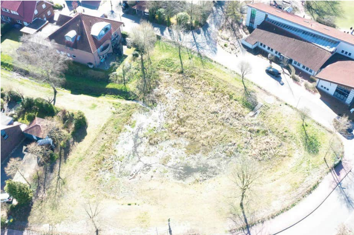
Bild: Erweitertes Regenrückhaltebecken
