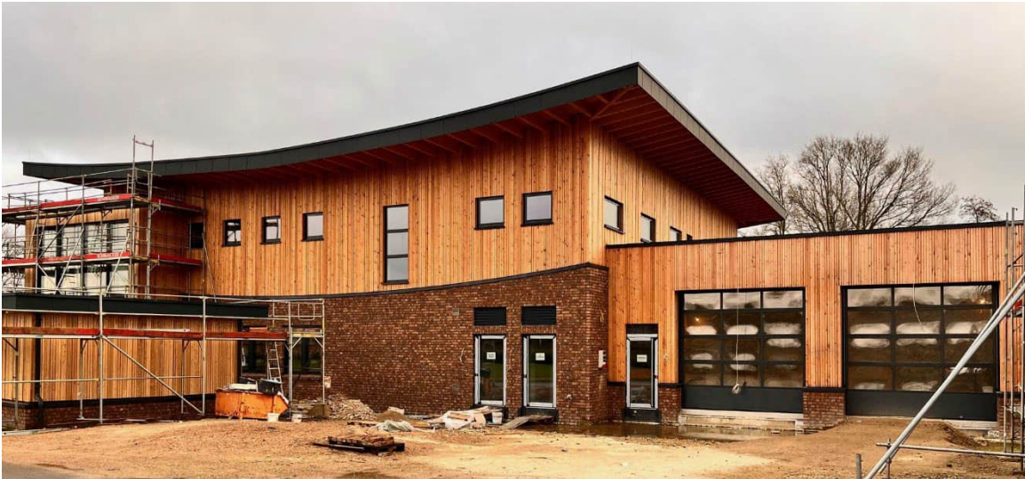
Bild: Nord Ansicht des im Bau befindlichen Betriebsgebäudes (Bild vom 07.01.2025)
