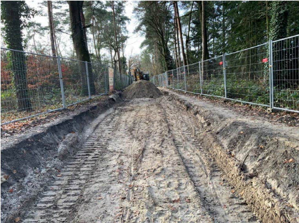
Welper Straße, Erd- und Kanalbauarbeiten Höhe Welper Wald (Dezember 2023)
